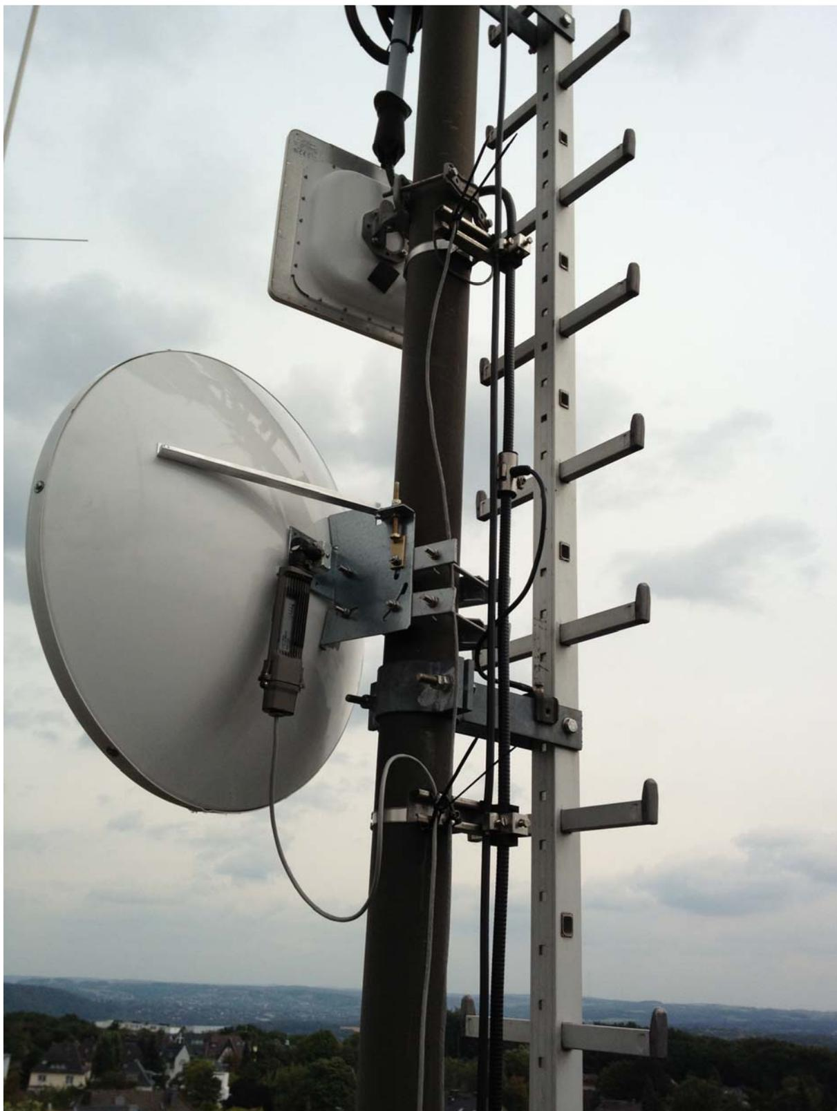
**Bild 1:** Für Richtfunkstrecken verwendete Antennentypen am Beispiel DB0GOS in Essen
