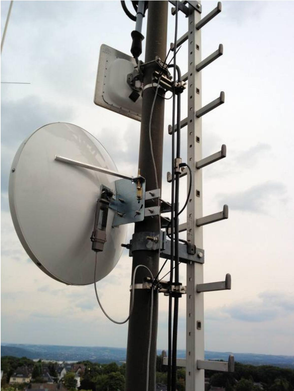
*Bild: Für Richtfunkstrecken verwendete Antennentypen und Outdoor-Units am Beispiel von DB0GOS in Essen (198m ü. NN)*
